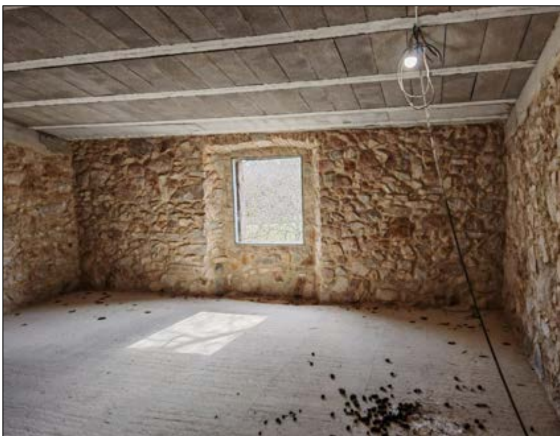
Il·lustració 64: Fotografia des del nord de l'àmbit 11.
