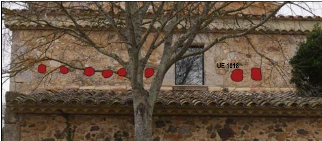
Il·lustració 26: Fotografia des de l'est de la zona superior de la façana est.
