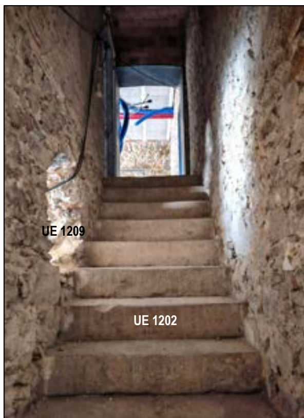
Il·lustració 43: Fotografia del tram d'escaleres des de l'oest.
