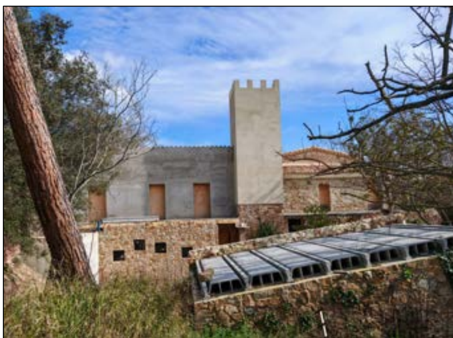
Il·lustració 165: Fotografia de la façana oest.
