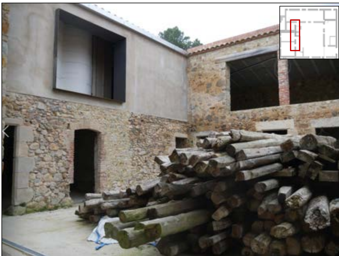
Il·lustració 100: Fotografia de l'estat actual de la façana oest de l'E5.
