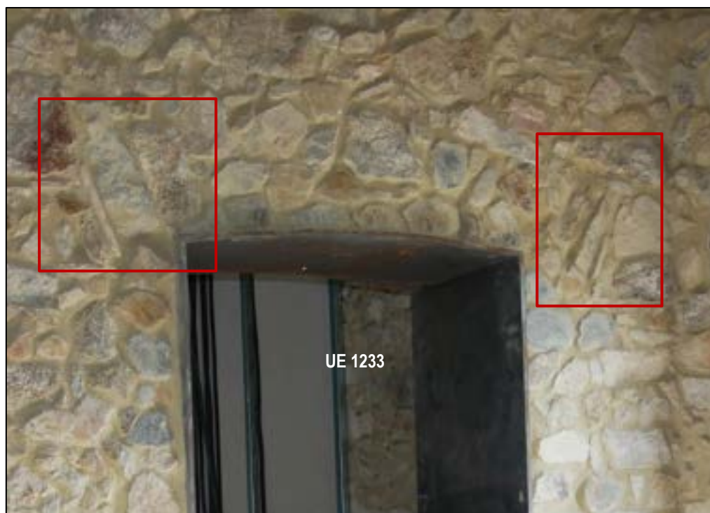
Il·lustració 62: Fotografia de detall de l'arrencament d'arc de descàrrega d'ela UE 1233.
