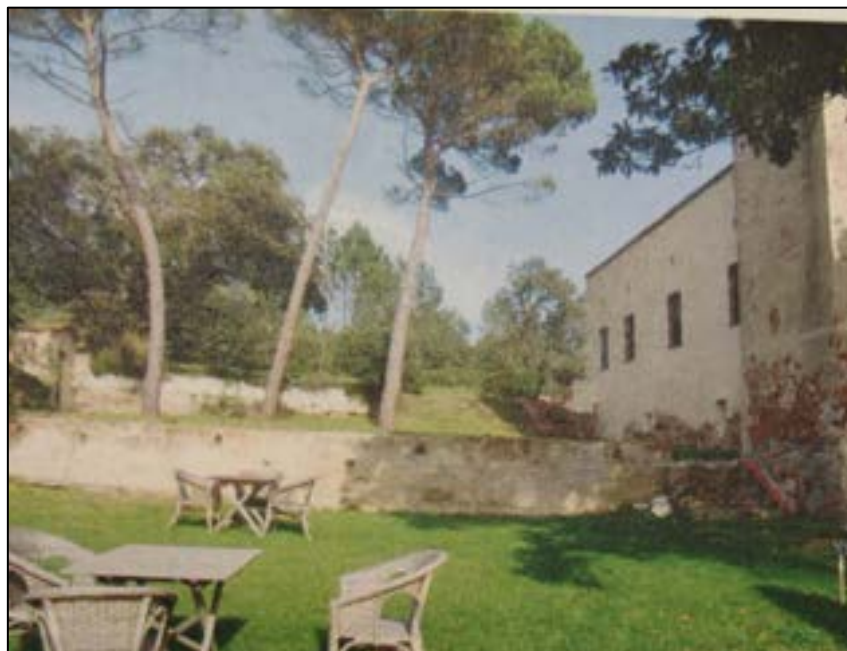
Il·lustració 129: Fotografia des del sud del mur de contenció l'any 2005. Font: Exp 2004/1149, AMCS.
