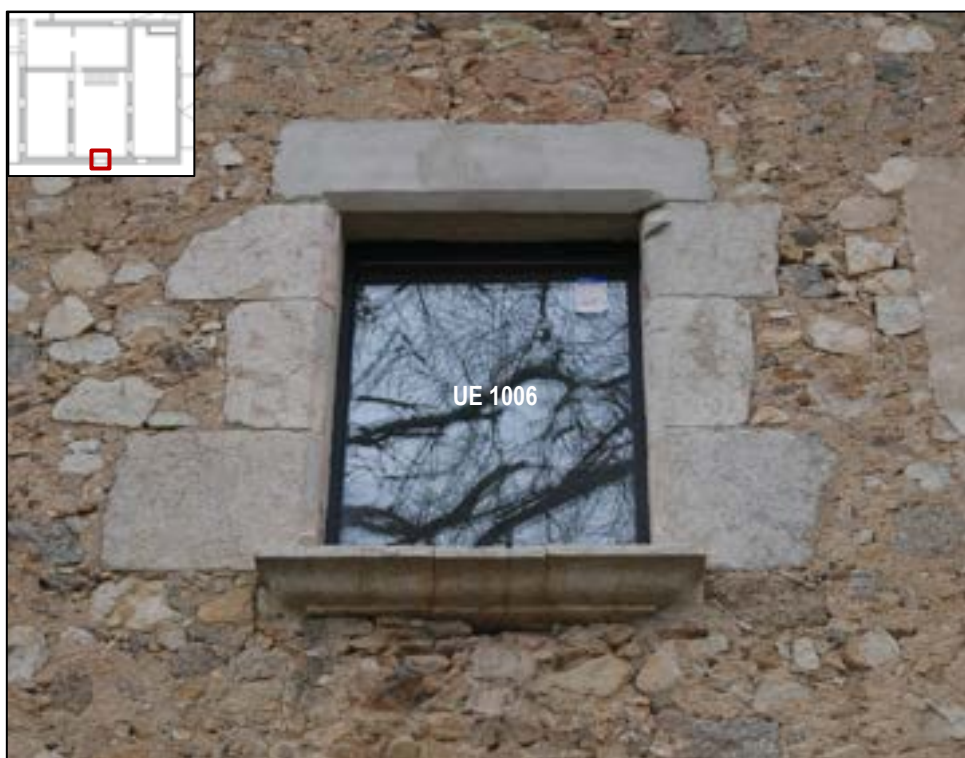
Il·lustració 15: Fotografia de la finestra central, UE 1006, on s'aprecia la reconstrucció de la llinda.
