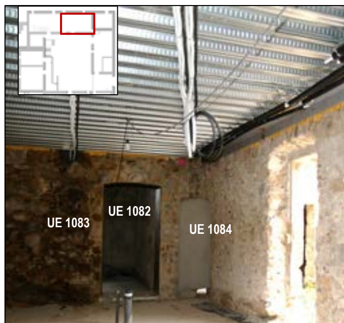
Il·lustració 98: Fotografia de l'interior de l'E5 des de l'oest.
