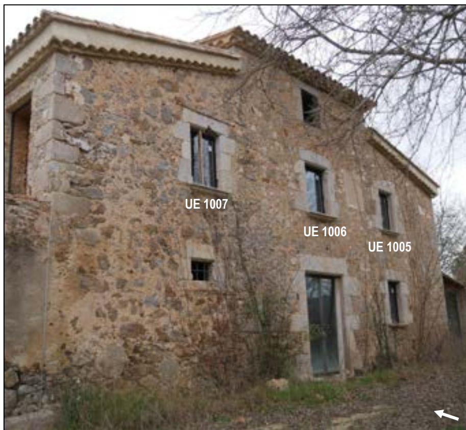
Il·lustració 13: Fotografia des del sud-oest de la façana principal de l'edifici.
