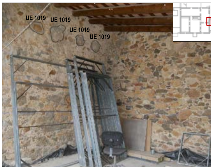
Il·lustració 28: Fotografia des del sud-est de les negatives UE's 1019.
