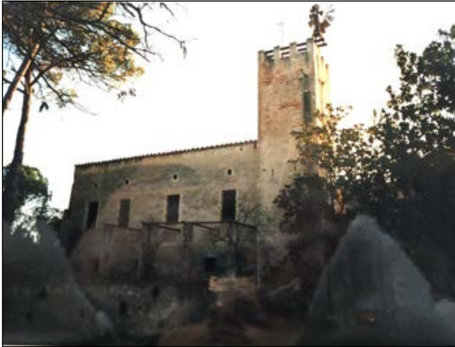
Il·lustració 134: Fotografia del bloc construït sobre l'E6. Font: Exp. 1999/374, AMCS.
