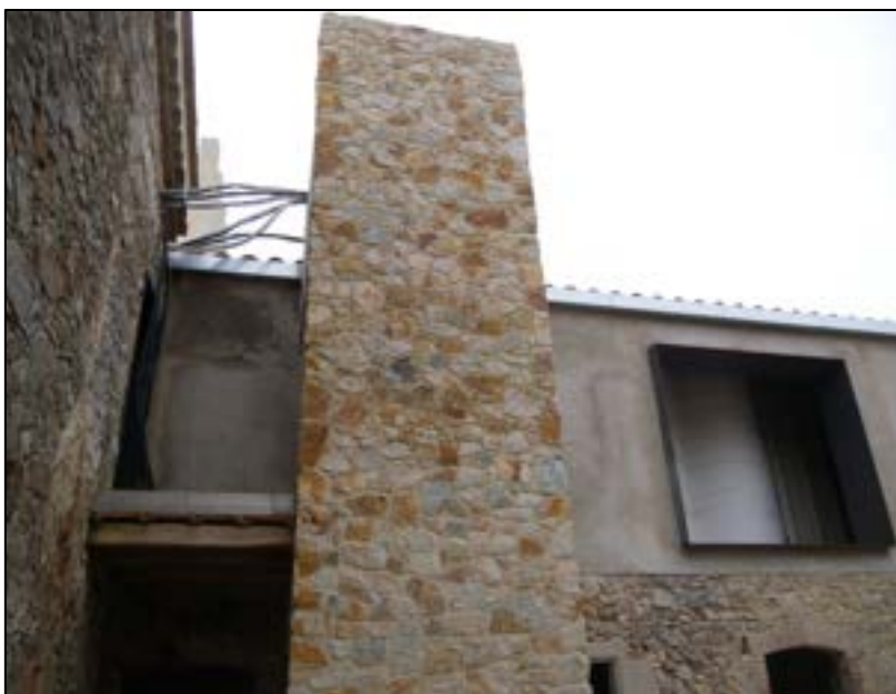
Il·lustració 163: Fotografia de la construcció del pati.
