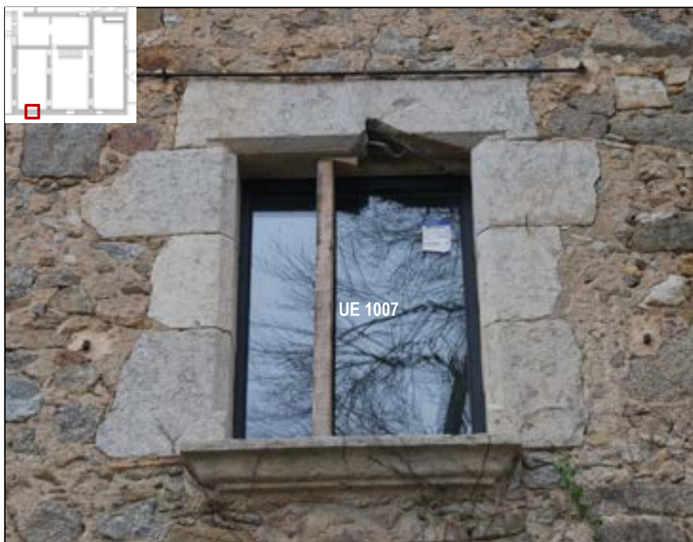
Il·lustració 16: Fotografia de la UE 1007 on s'observa el mal estat de la llinda.
