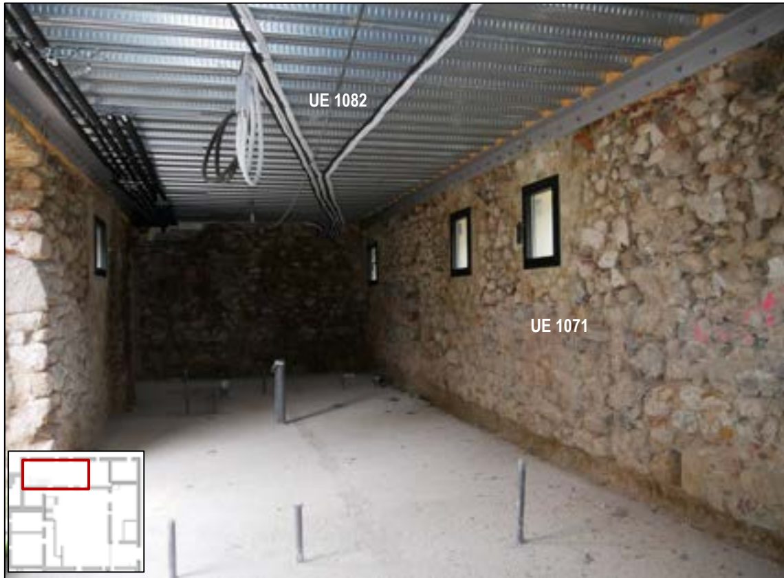
Il·lustració 97: Fotografia des de l'est de l'interior de l'E5.
