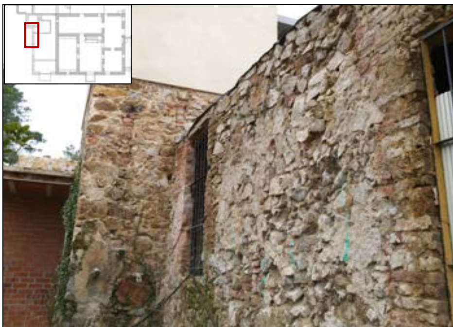
Il·lustració 70: Fotografia des del sud-oest del contacte amb la E8.
