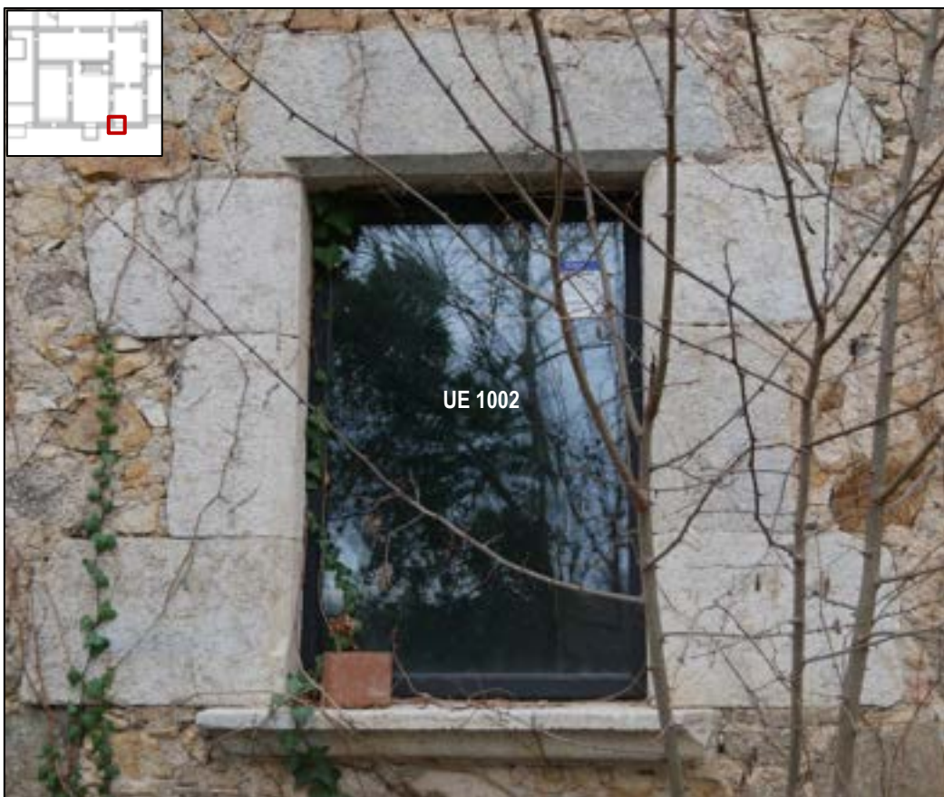
Il·lustració 9: Fotografia de la finestra UE 1002 des de l'exterior i des de l'interior.
