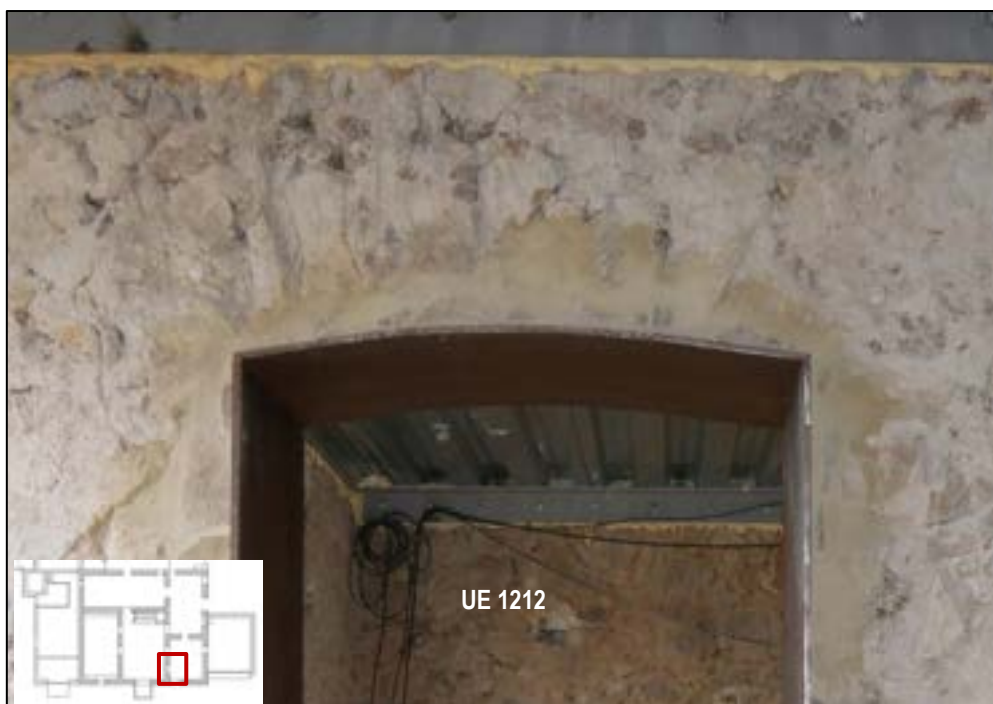
Il·lustració 46: Fotografia de l'arc de descàrrega documentat des de l'A4.
