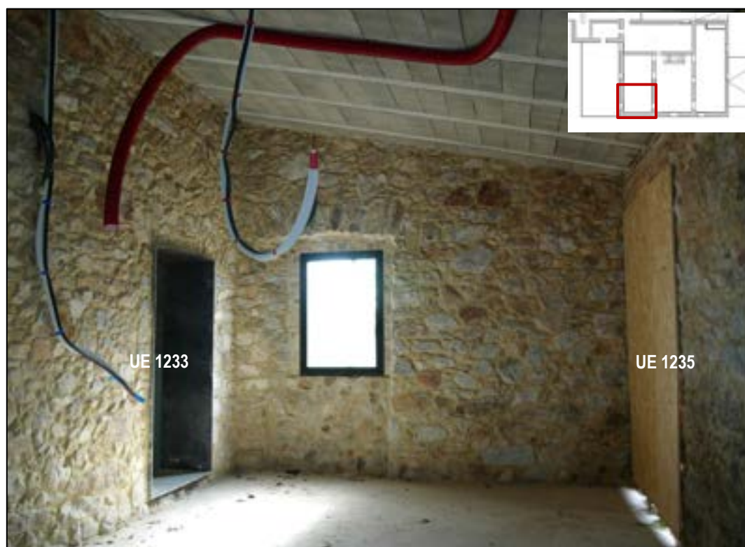
Il·lustració 61: Fotografia des del nord de l'àmbit 10.
